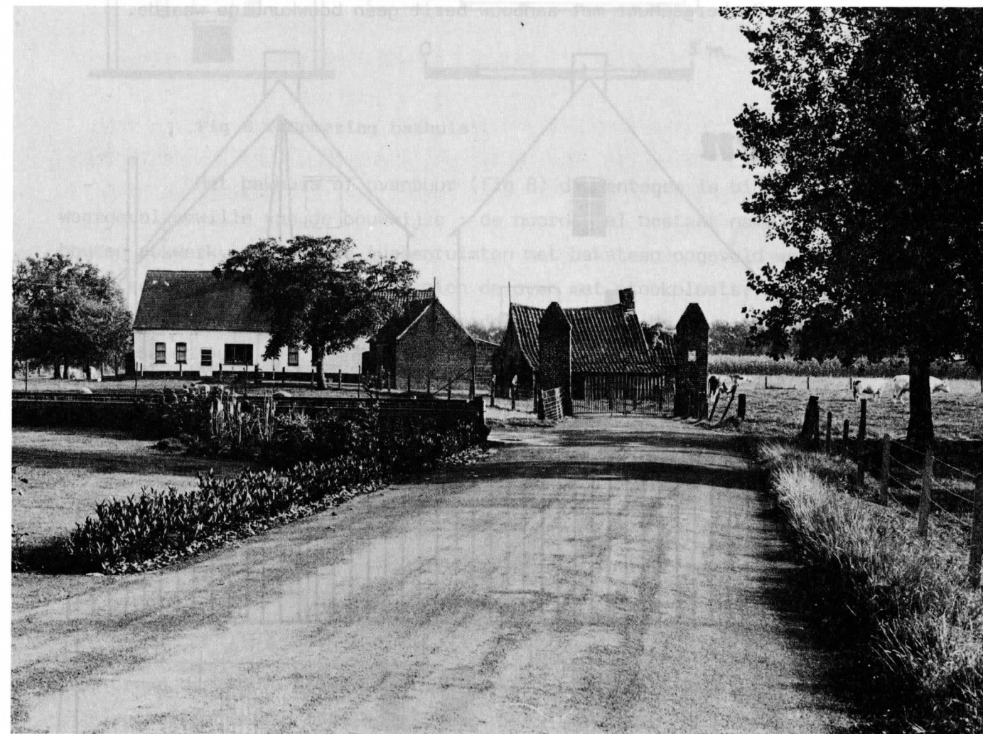
Fig 6 : Algemeen zicht op de hoeve. Foto Ph. Despriet 1976;
